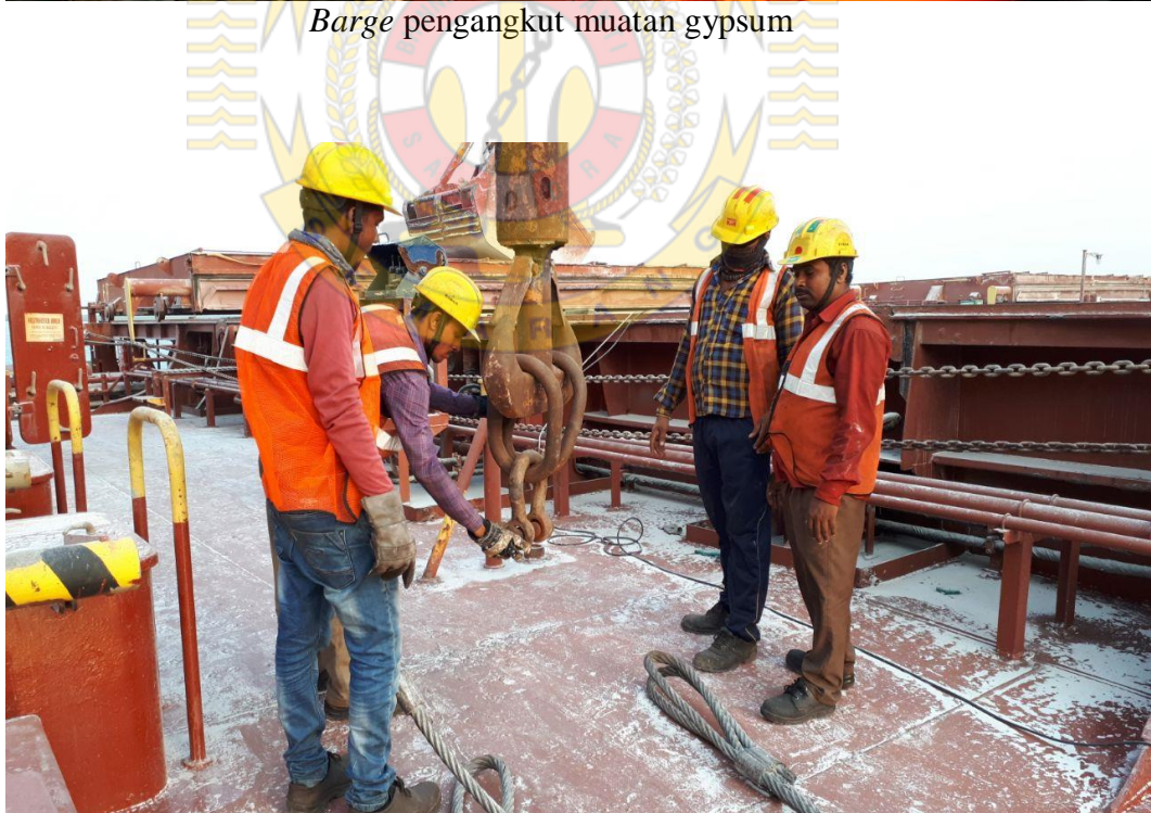
Proses pemasangan shore grab bucket
