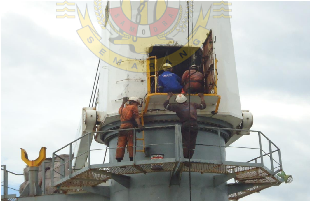
Proses penggantian wire pada crane .
