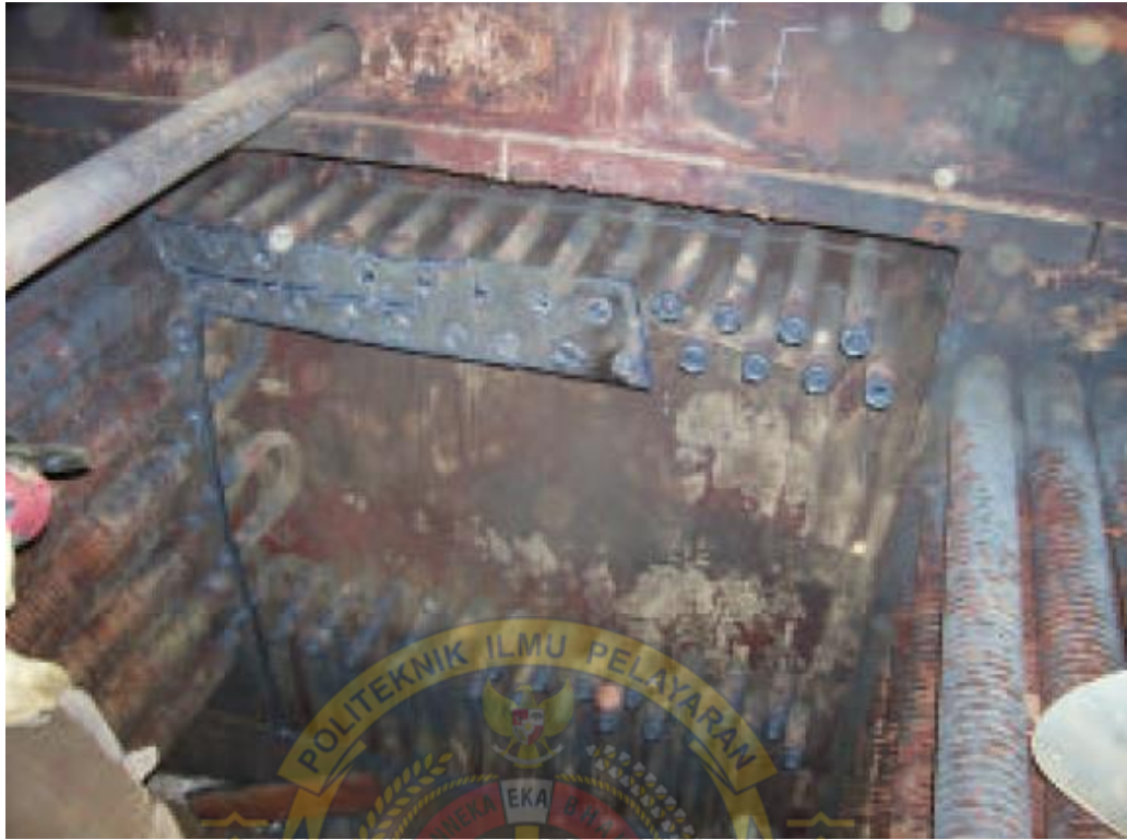
Pemotongan pada pipa EGE
