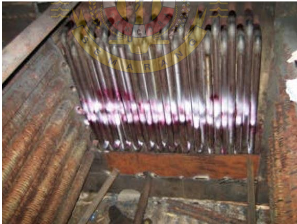
Pengelasan pada pipa EGE
