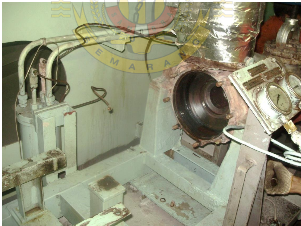
Pelepasan Pompa
