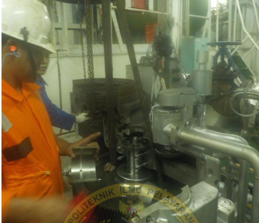
Gambar Proses pemasangan turbin uap pada cargo oil pump (halaman 2)
