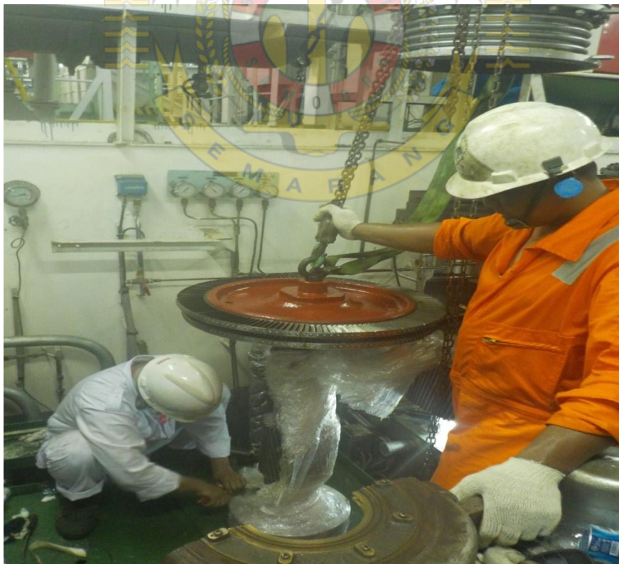
Gambar Proses pemasangan turbin uap pada cargo oil pump (halaman 2)
