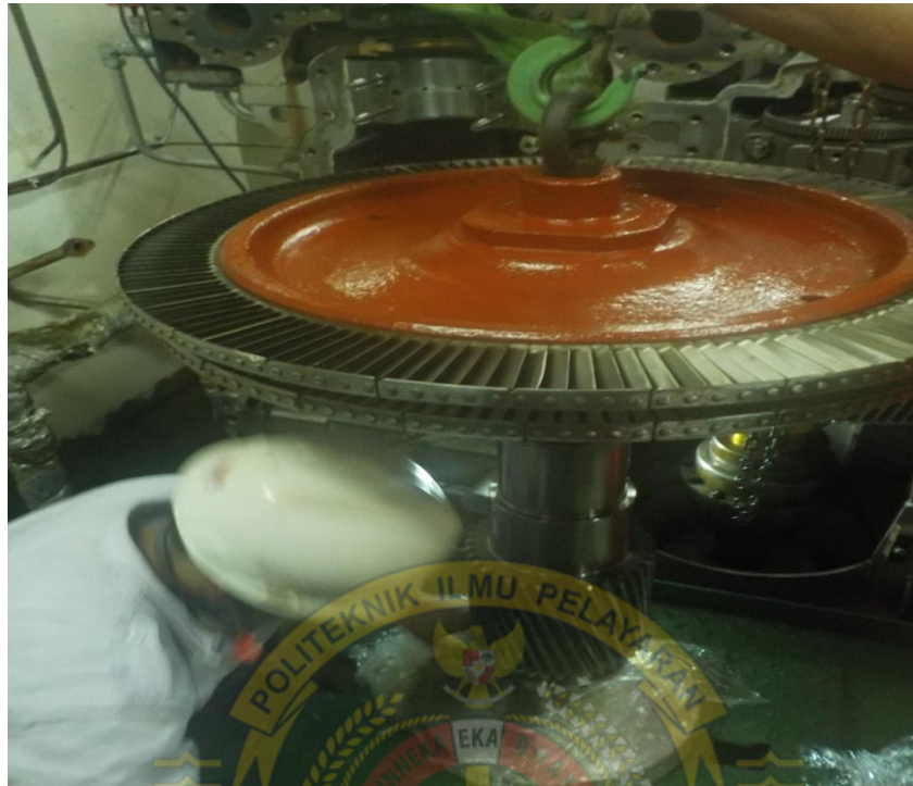
Gambar Setelah perbaikan sudu-sudu turbin uap pada cargo oil pump (halaman 2)
