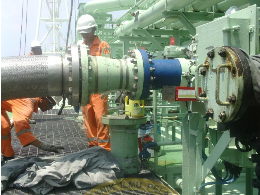
Pelaksanaan Leak Test di manifold
