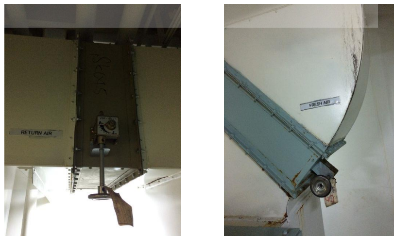
Gambar 4.23 knop pengatur inlet udara
