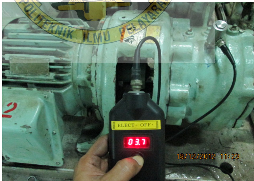
Gambar : vibration check pada boiler feed water pump
