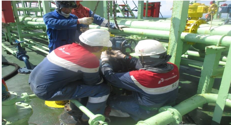
Gambar 4. Proses pemasangan kembali valve cargo yang diganti
