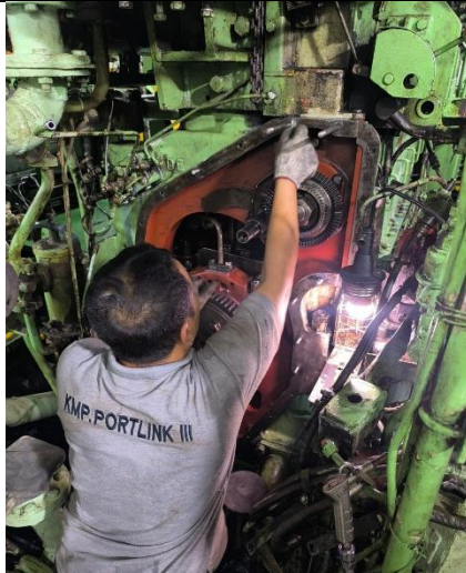
Pembongkaran diesel generator
