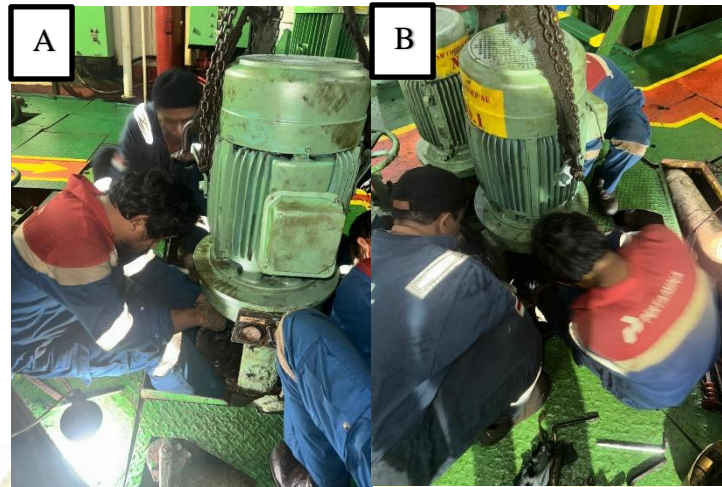
Gambar 5. 1. aA overhaul pompa B. Pemasangan instalasi pompa
