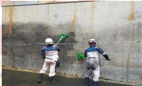
Gambar 2. 6 Mopping dinding ruang muat menggunakan cotton rubber mop
