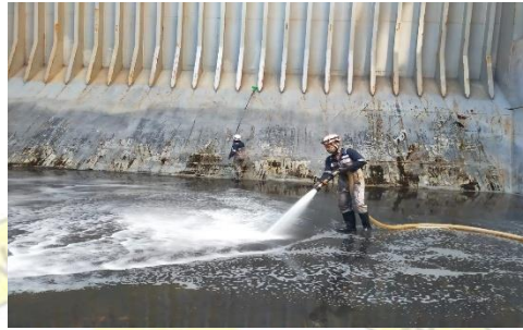
Gambar 2. 5 Penyemprotan air laut menggunakan nozzle dan hose Sumber: Dokumen Penelitian (2024)
