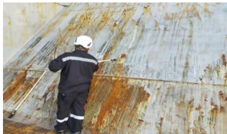
Gambar 2. 4 Scraping menggunakan scraper Sumber: Dokumen Penelitian (2024)
