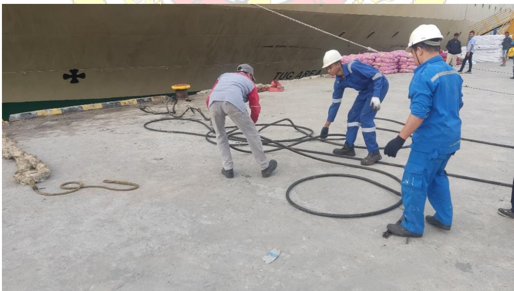
Lampiran 4 Penggantian Wire Crane yang putus
