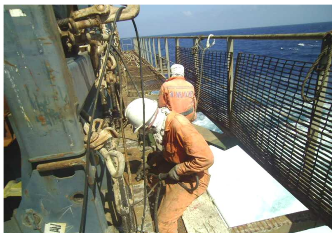
Gambar Lam.15 Perawatan Lashing Bridge di Laut.
