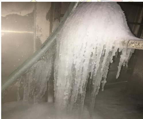
Gambar 3 Tampak bunga es dari sisi bawah evaporator
