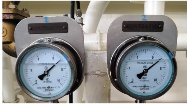
Gambar 2. 5 Tekanan udara pada main air reducing .
