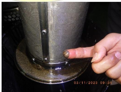
Gambar 4. 12 Gambar kontaminasi geram-geram pada LO filter Sumber: Dokumentasi pribadi
