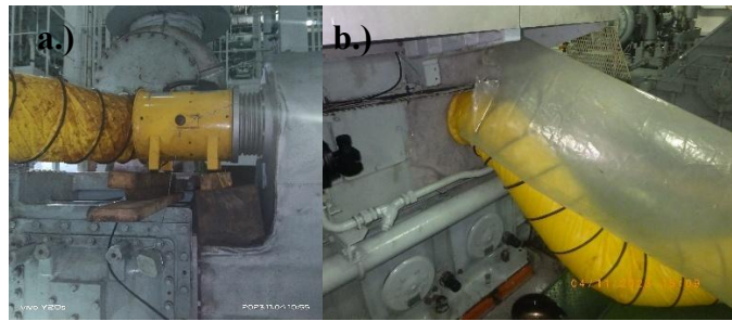
Gambar 4. 14 a.) pemasangan blowe portable pada intercooler . b.) pemasangan saluran udara pada scaving box Sumber: Dokumentasi pribadi
