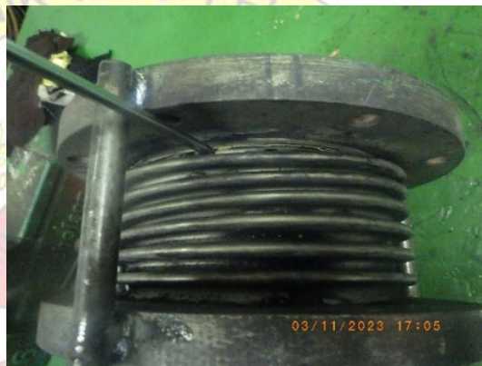
Gambar 4. 17 Gambar pengelasan flexible hose exhaust gas line Sumber: Dokumentasi pribadi
