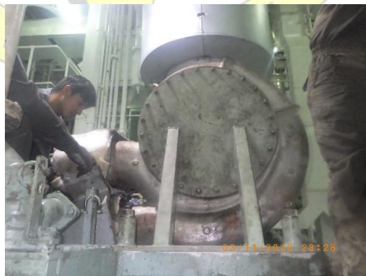
Gambar 4. 16 Gambar pemasangan blank pada TC ME Sumber: Dokumentasi pribadi
