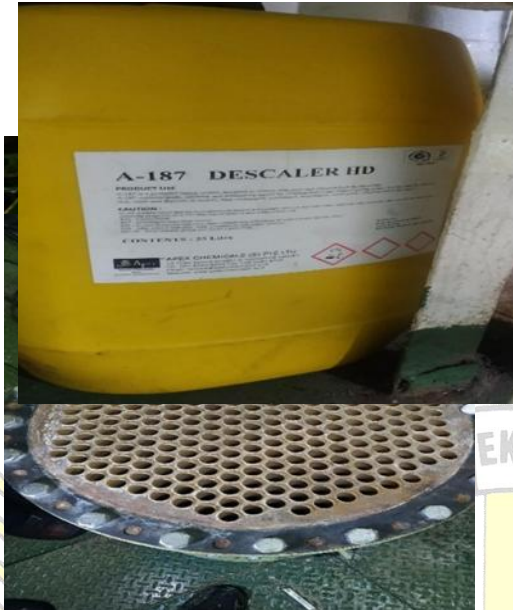
Gambar 13. Kondisi evaporator setelah dibersihkan
