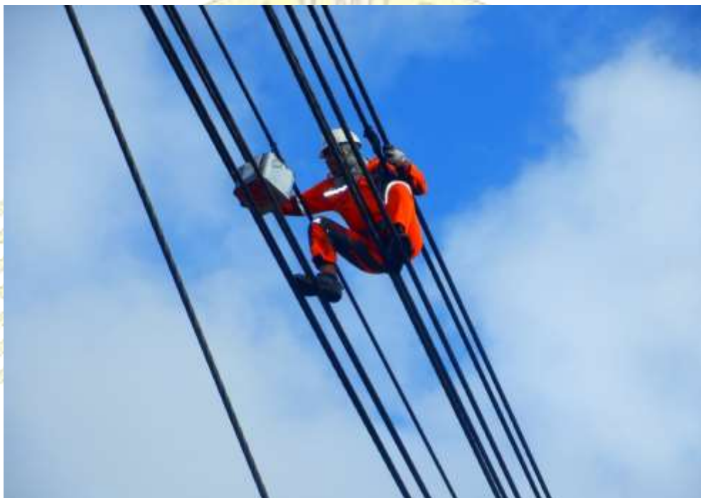
Gambar 6.4 Perawatan Crane Wire Rope Sumber: Dokumen Kapal (2022)
