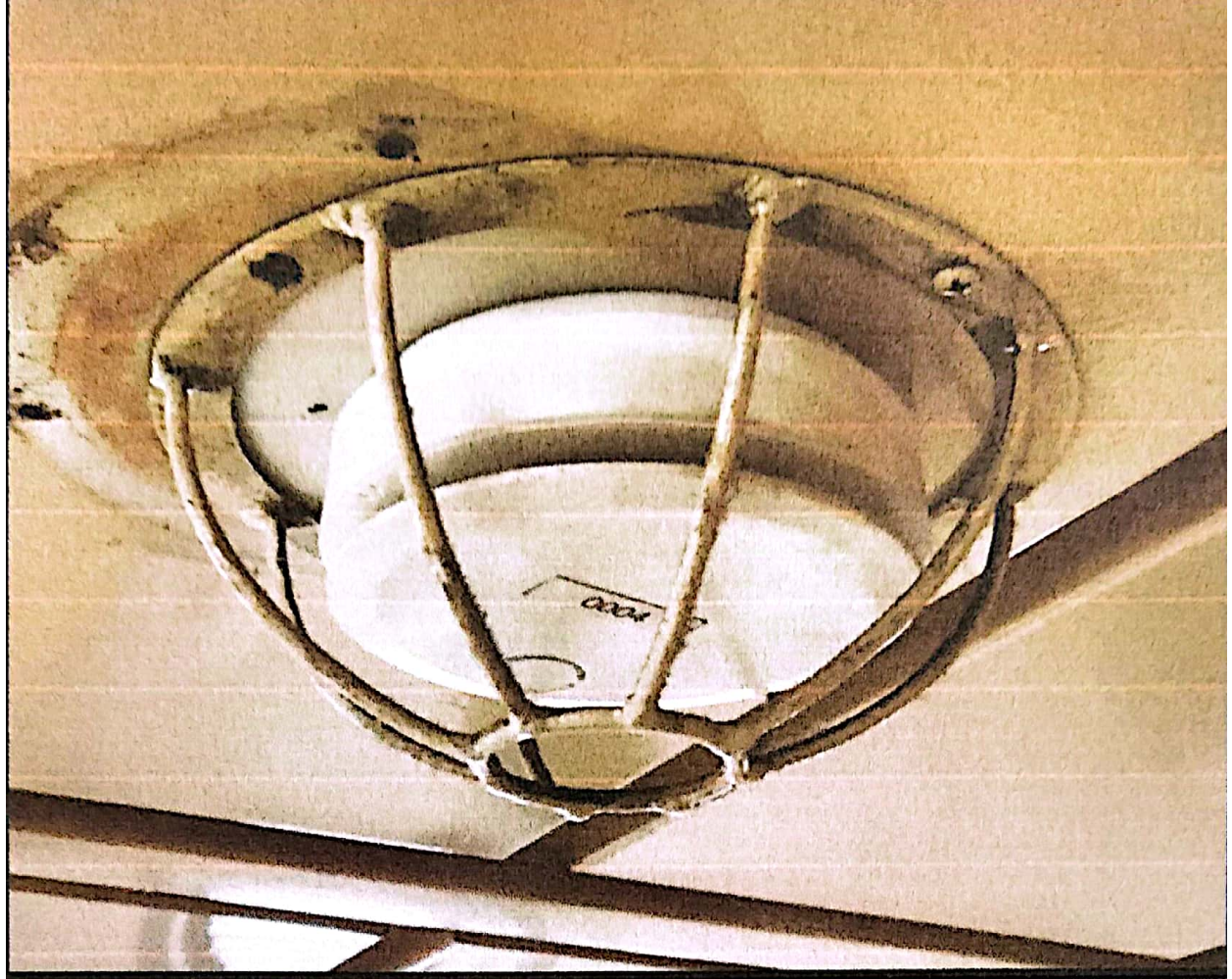
Gambar 9 : Smoke Detector Sumber : Dokumentasi Pribadi
