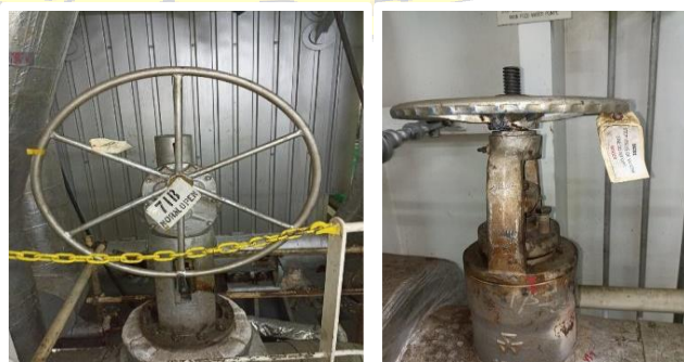
Gambar 2.7 Katup utama dan katup bantu Sumber: Dokumentasi Peneliti 2023
