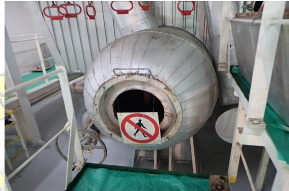
Gambar 2.3 Water drum Sumber: Dokumentasi Peneliti 2023
