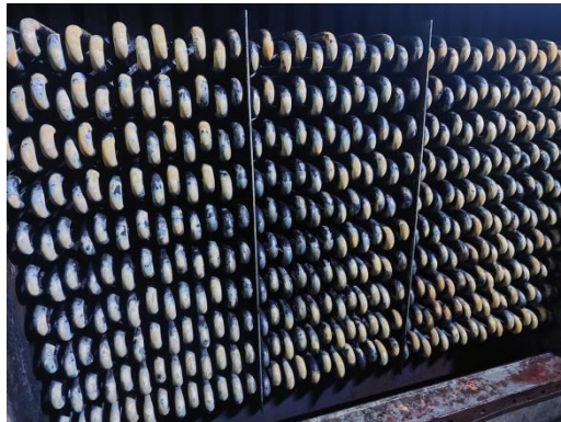
Gambar 2.2 Exhaust Gas Economizer 1 Sumber: Dokumentasi pribadi (2022)
