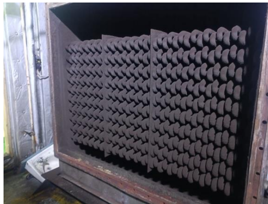
Gambar 2.3 Exhaust Gas Economizer 2 Sumber: Dokumentasi pribadi (2022)
