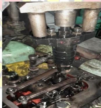
Gambar 2.4 Pelepasan *Injector* dari *Cylinder Head* DG
