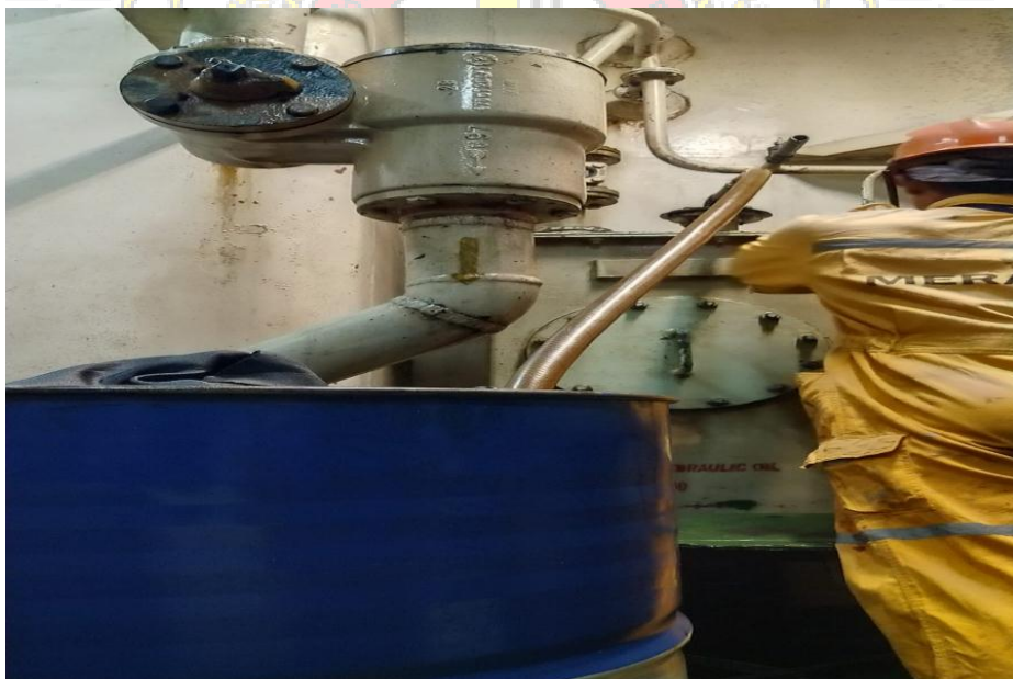
Lampiran 12 Proses pengisian oli pada mesin crane
