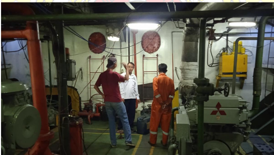
foto pemeriksaan alat keselamatan kapal di ruang mesin
