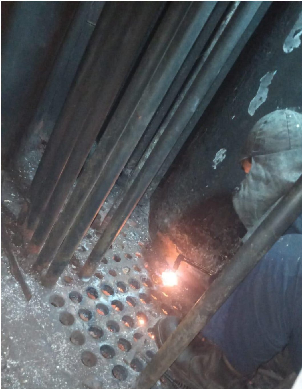
Lampiran 18 : Penggantian pipa boiler ketika kapal MV. DK 02 labuh
