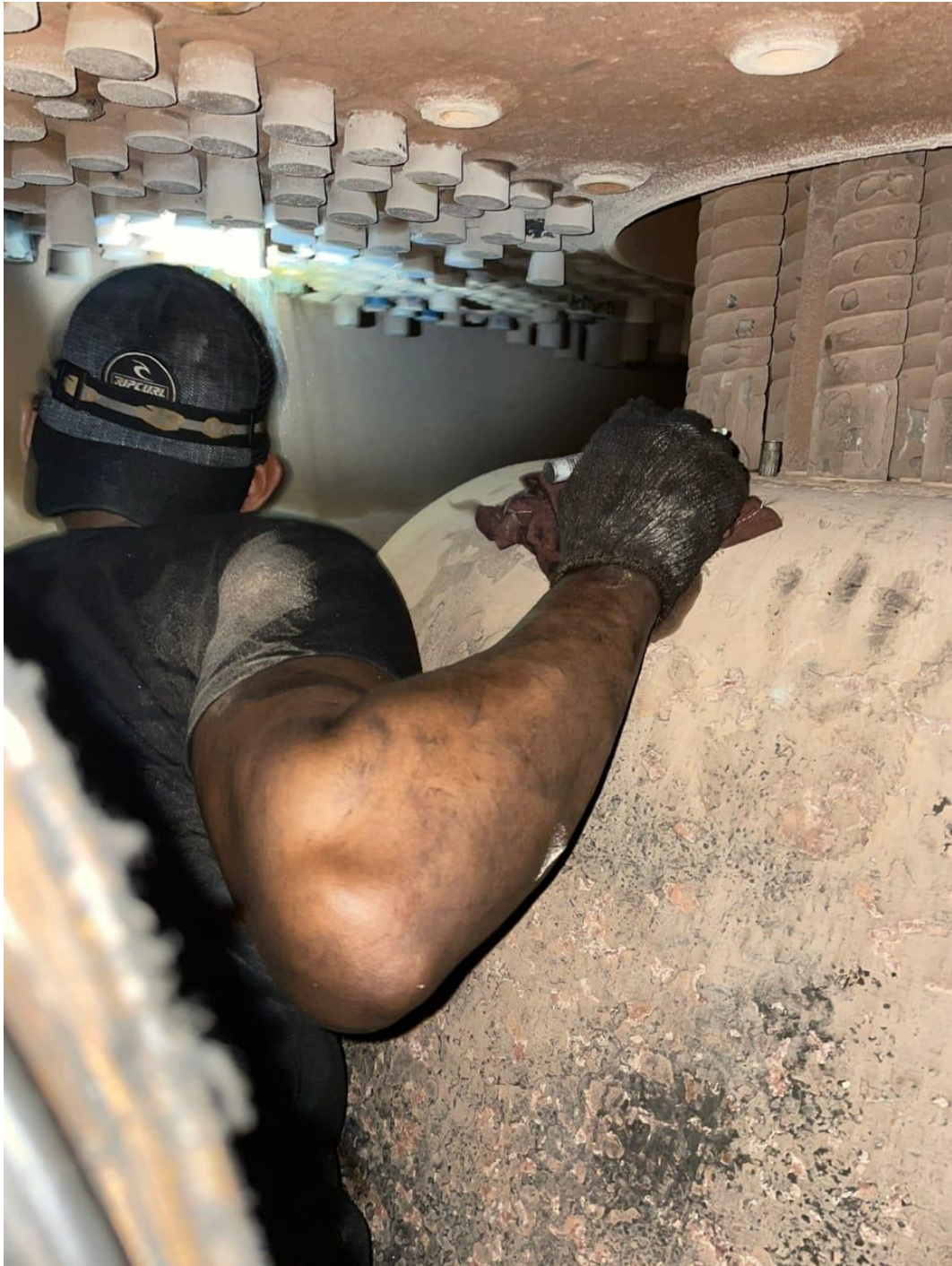
Lampiran 17 : Perbaikan boiler kapal MV. DK 02 ketika labuh
