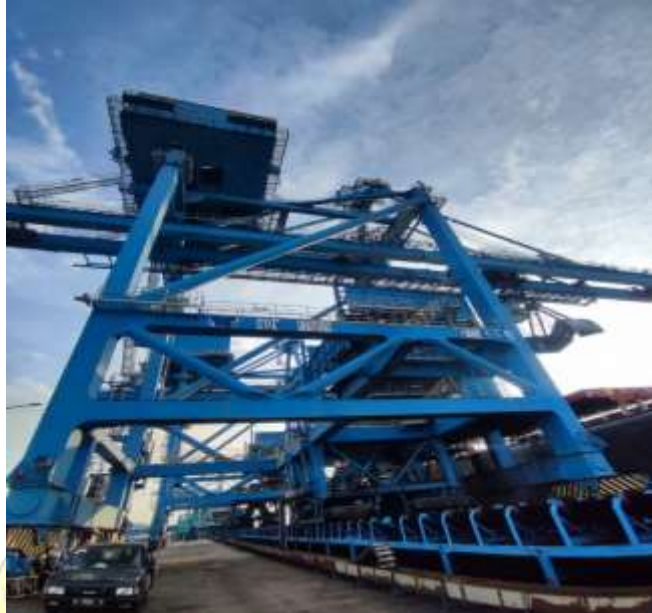
Gambar 2. 1 Crane Darat Sumber : Dokumentasi Pribadi
