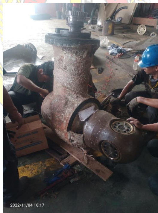
Gambar 2. Proses perbaikan di workshop galangan
