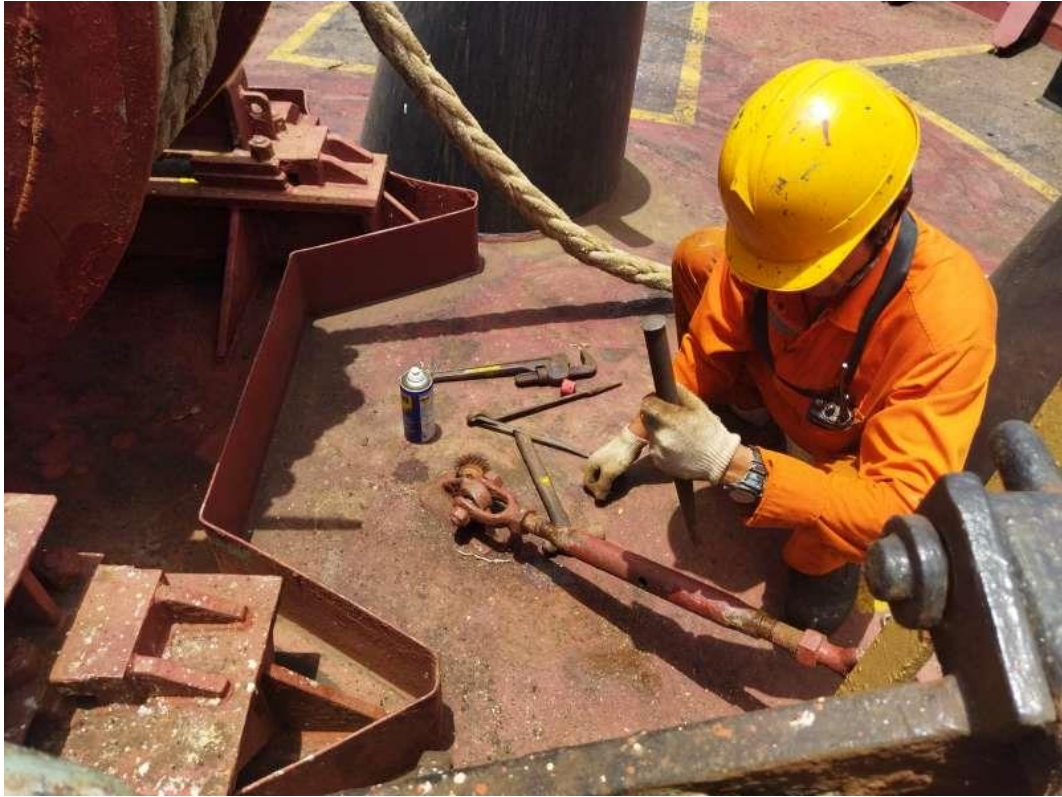
Perawatan pada stopper anchor (Sumber: Dokumen Pribadi Peneliti)
