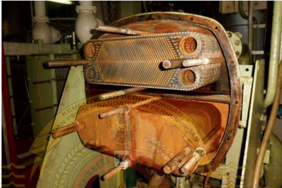
Dokumentasi plat plat Evaporator dan Kondenser dalam keadaan kotor
