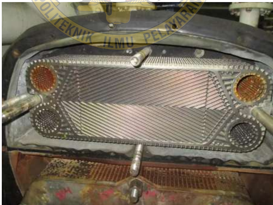
Dokumentasi kondisi Fresh Water Generator setelah dilakukan pembersihan
