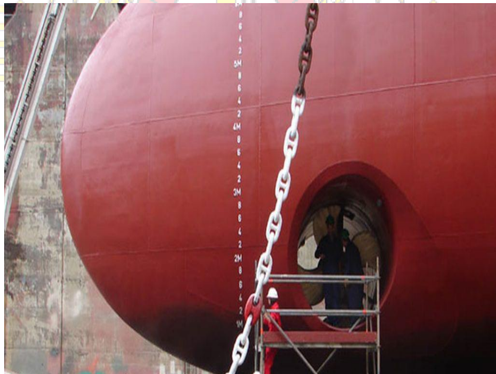
Gambar 4.9 Perbaikan pada bow thruster di tempat docking
