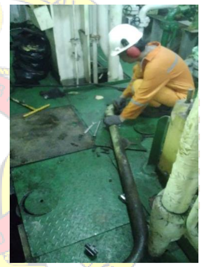
Pembersihan kerak pipa air pendingin (air laut)
