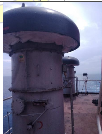
Filter blower setelah diganti
