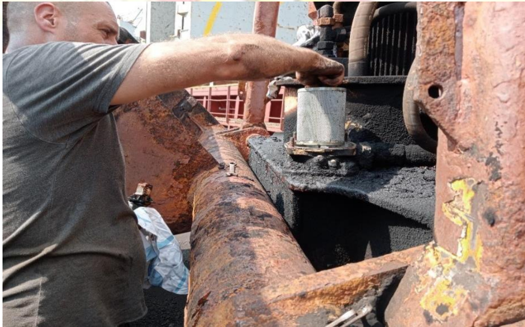
Perbaikan grabe Floating Crane
