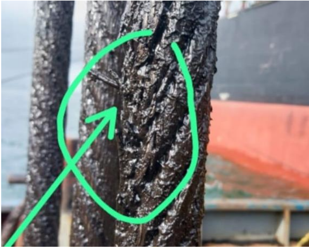
Wire grabe Floating Crane yang harus diganti
