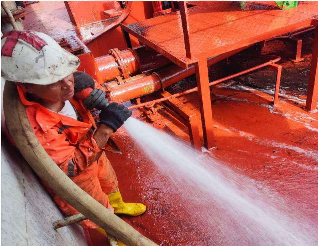
Main deck yang telah dibersihkan
