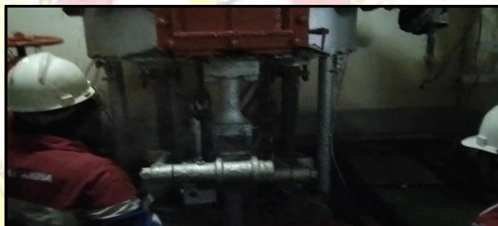
Gambar 2 2 Stripping MT. Gebang
