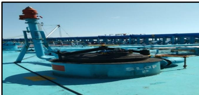
Gambar 2. 3 Slop Tank MT. Gebang Sumber : Dokumen Pribadi
