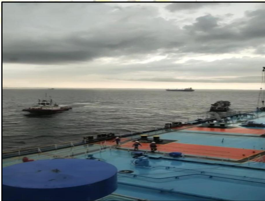
Kegiatan Pemasangan Fender
