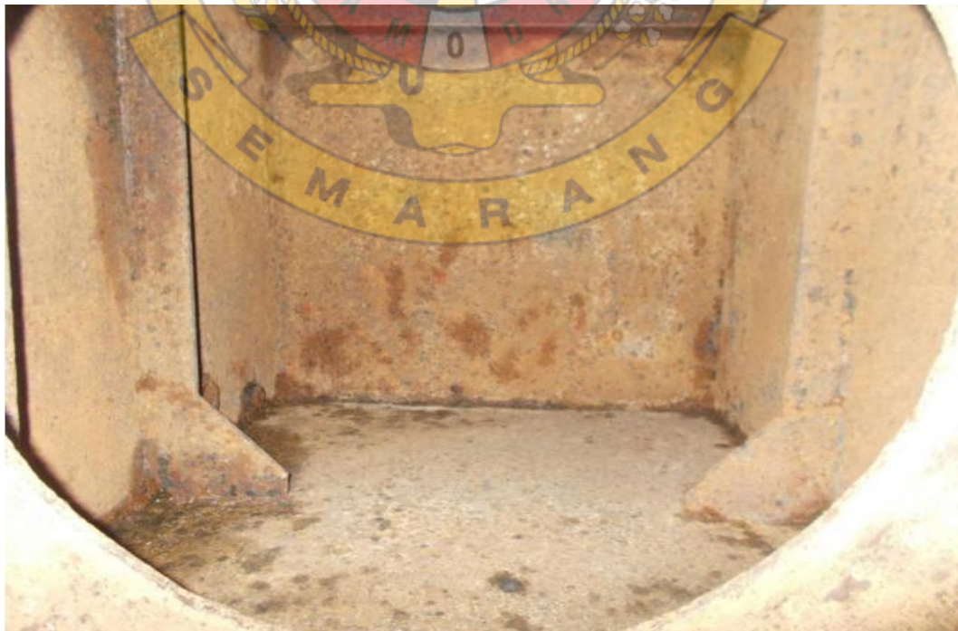
Kondisi sesudah dikuras
