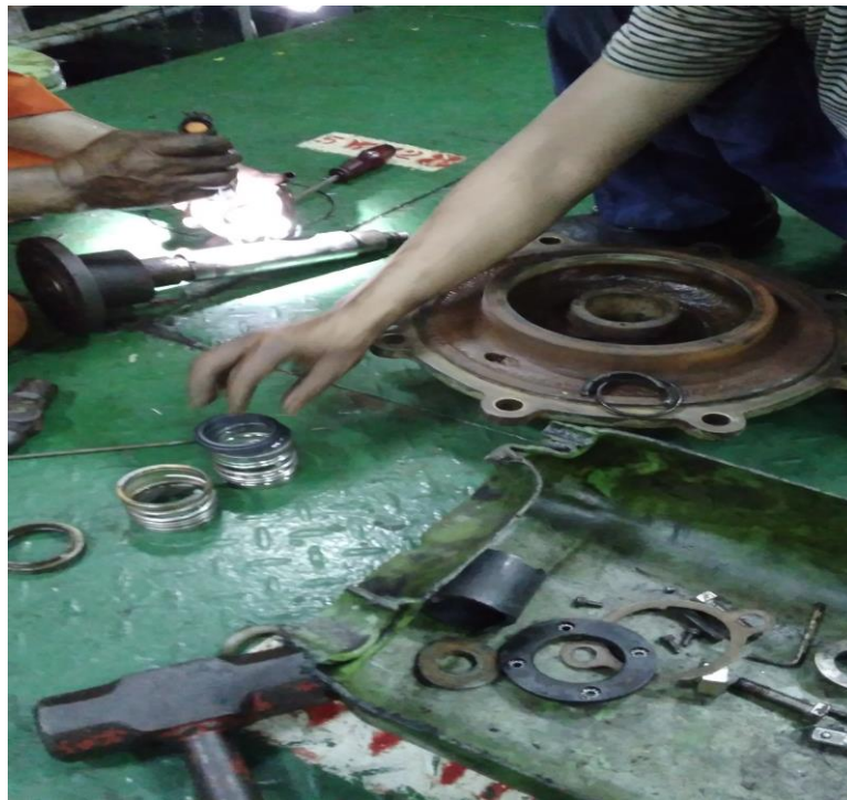
Gambar Proses Pemasangan Sparepart Pompa
