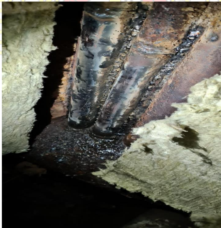
Pipa Setelah Dilakukan Perbaikan
