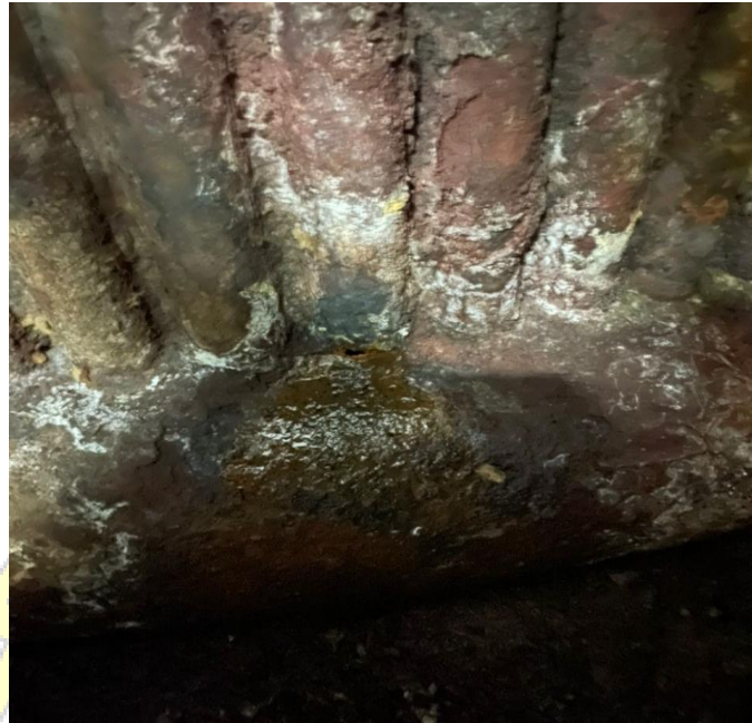
Pipa Setelah Dilakukan Perbaikan
