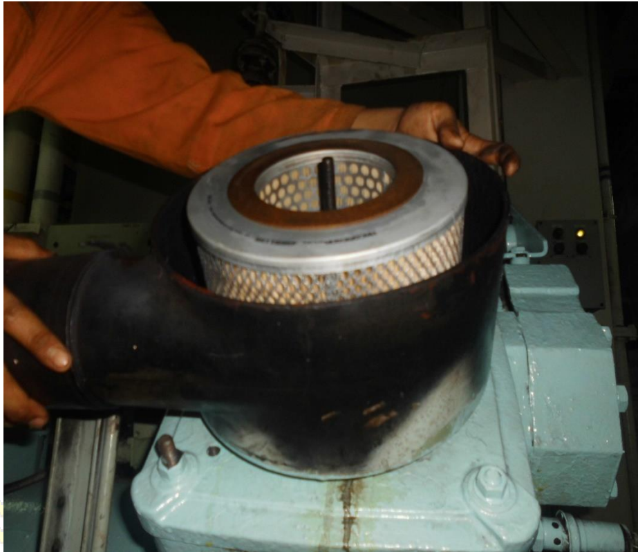
Gambar Kondisi pemasangan Filter Inlet yang baru
