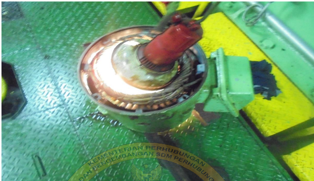
Foto pengeringan stator
