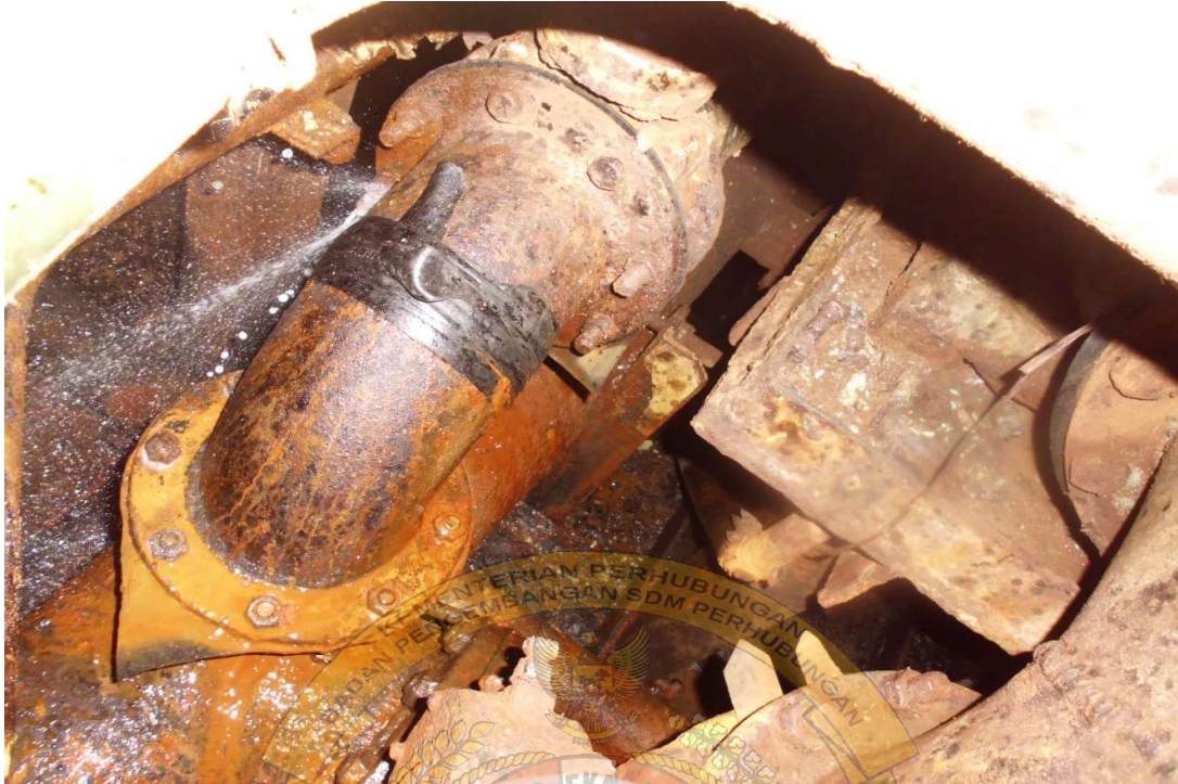
Gambar Kebocoran Instalasi Pipa Pendingin Air Laut Sumber Data: Dokumentasi Kapal KM. Oriental Silver
