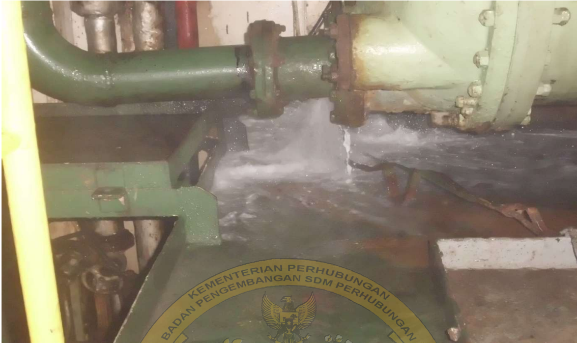
Gambar Kebocoran Instalasi Pipa Pendingin Air Laut Sumber Data: Dokumentasi Kapal KM. Oriental Silver
