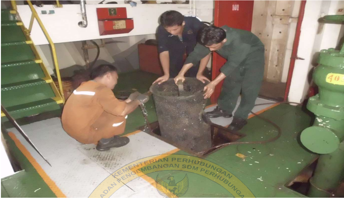
Gambar Proses Pemasangan Filter Sea Chest Sumber Data: Dokumentasi Kapal KM. Oriental Silver
