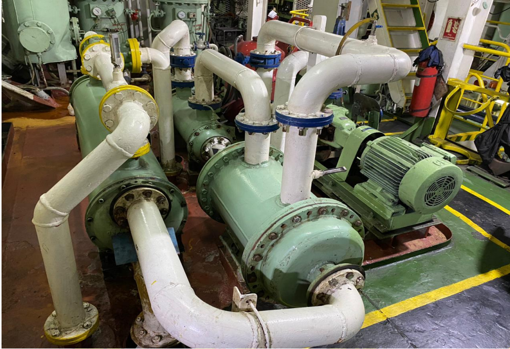
Gambar fresh water cooler setelah dicat.
