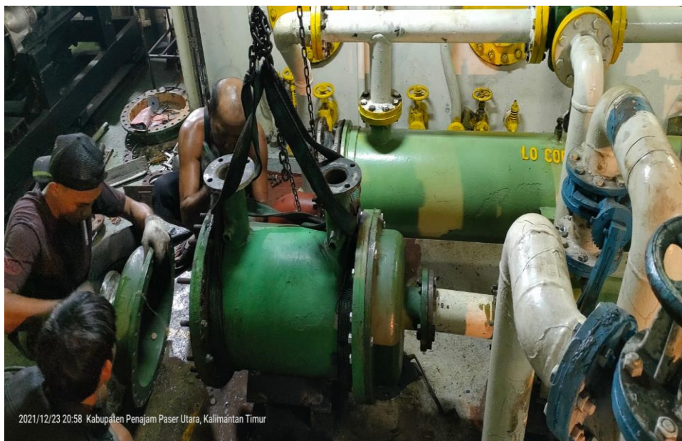
Gambar proses pemasangan fresh water cooler tambahan.
