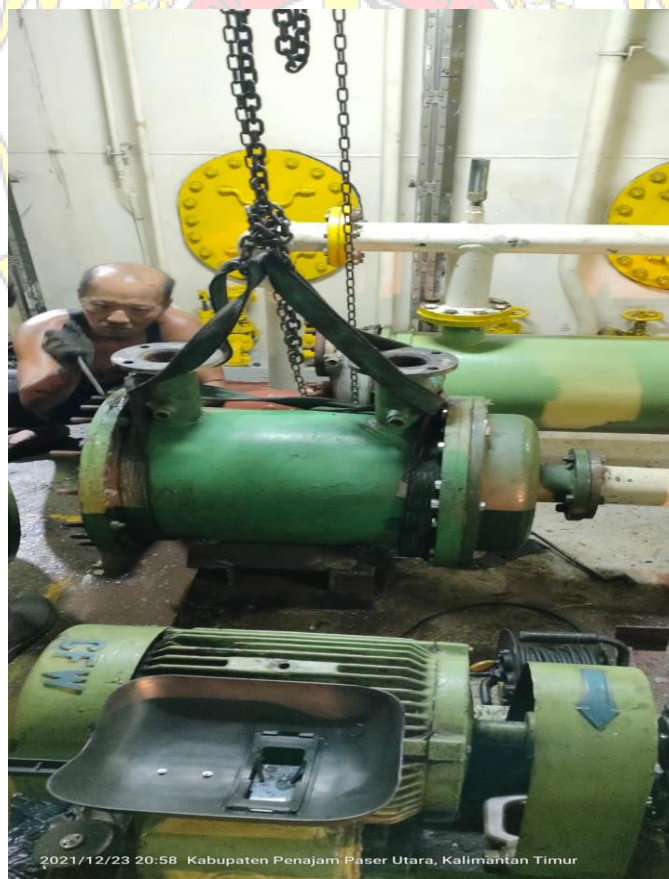
Gambar proses pemasangan fresh water cooler tambahan.
