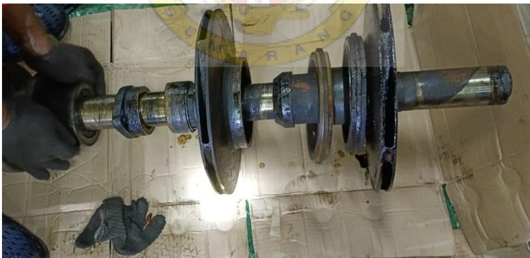
Kerusakan pada shaft beserta bagianya pada pompa main cooling sea water pump
