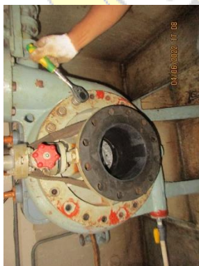
Mechanical seal yang terpasang
