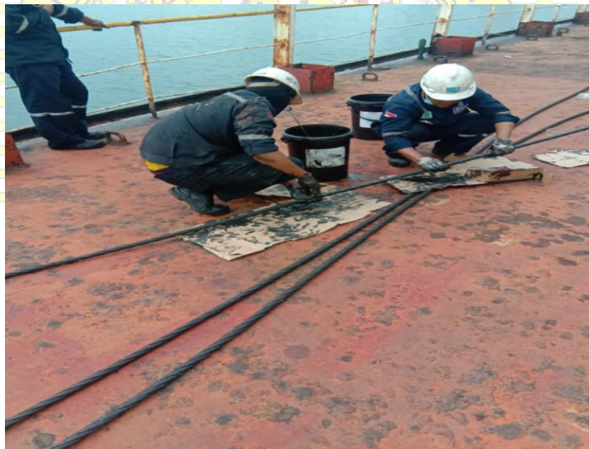
Pemberian grease pada wire crane sebelum di pasang
