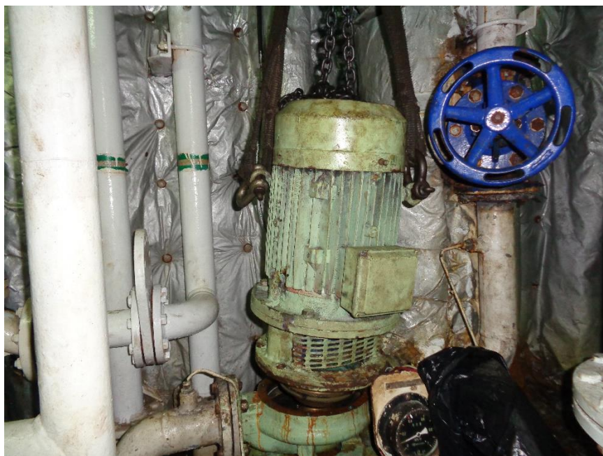
Proses Pengangkatan Electro Motor Ejektor Pump
