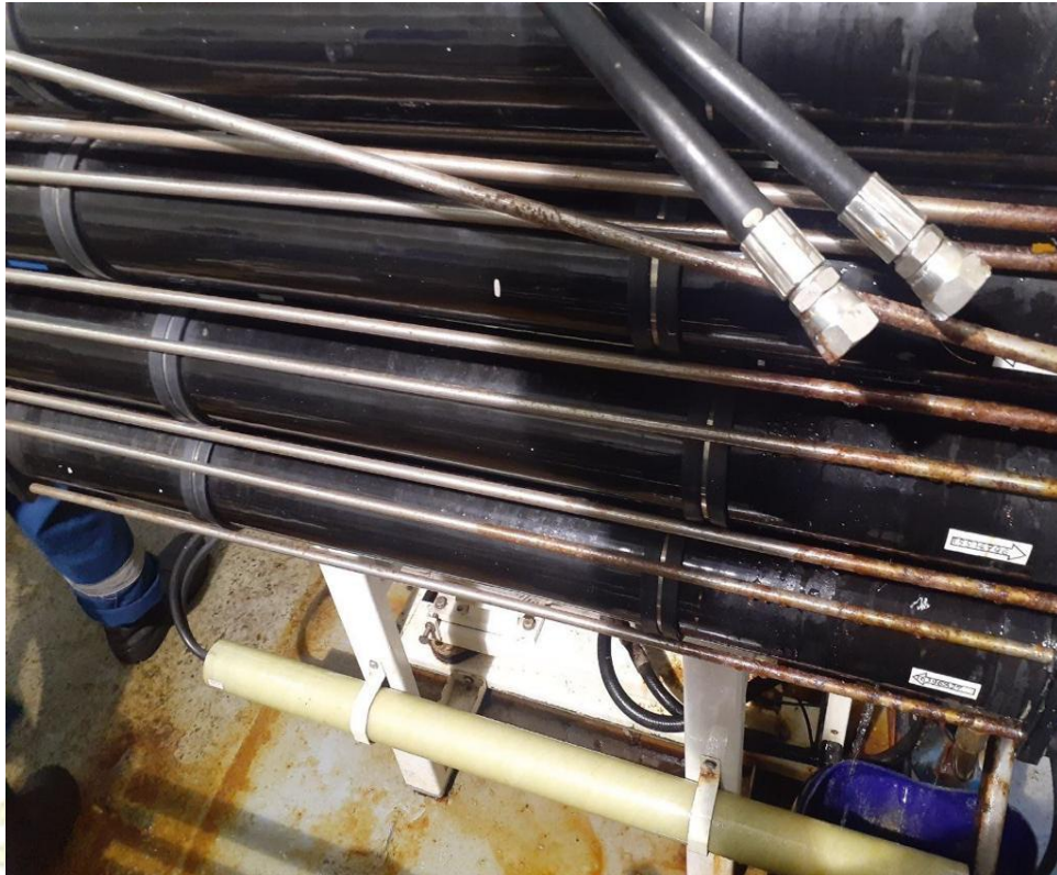
Gambar 24 : Pipa-Pipa Membran
