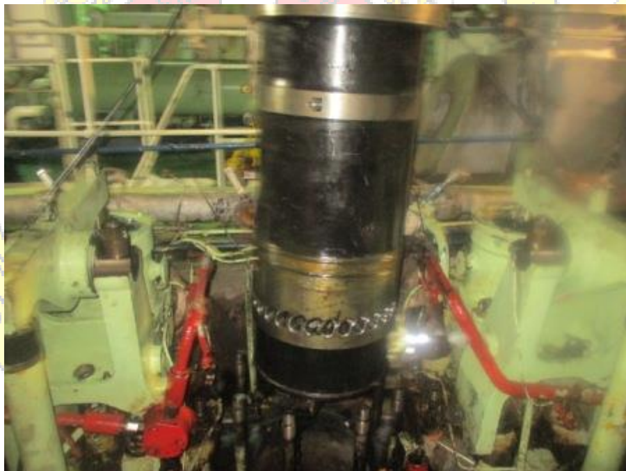
Gambar Penggantian Cylinder Liner dengan Spare baru
