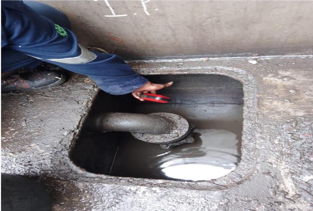
*test floating switch sensors pada palka nomor 1 oleh Electrician*
