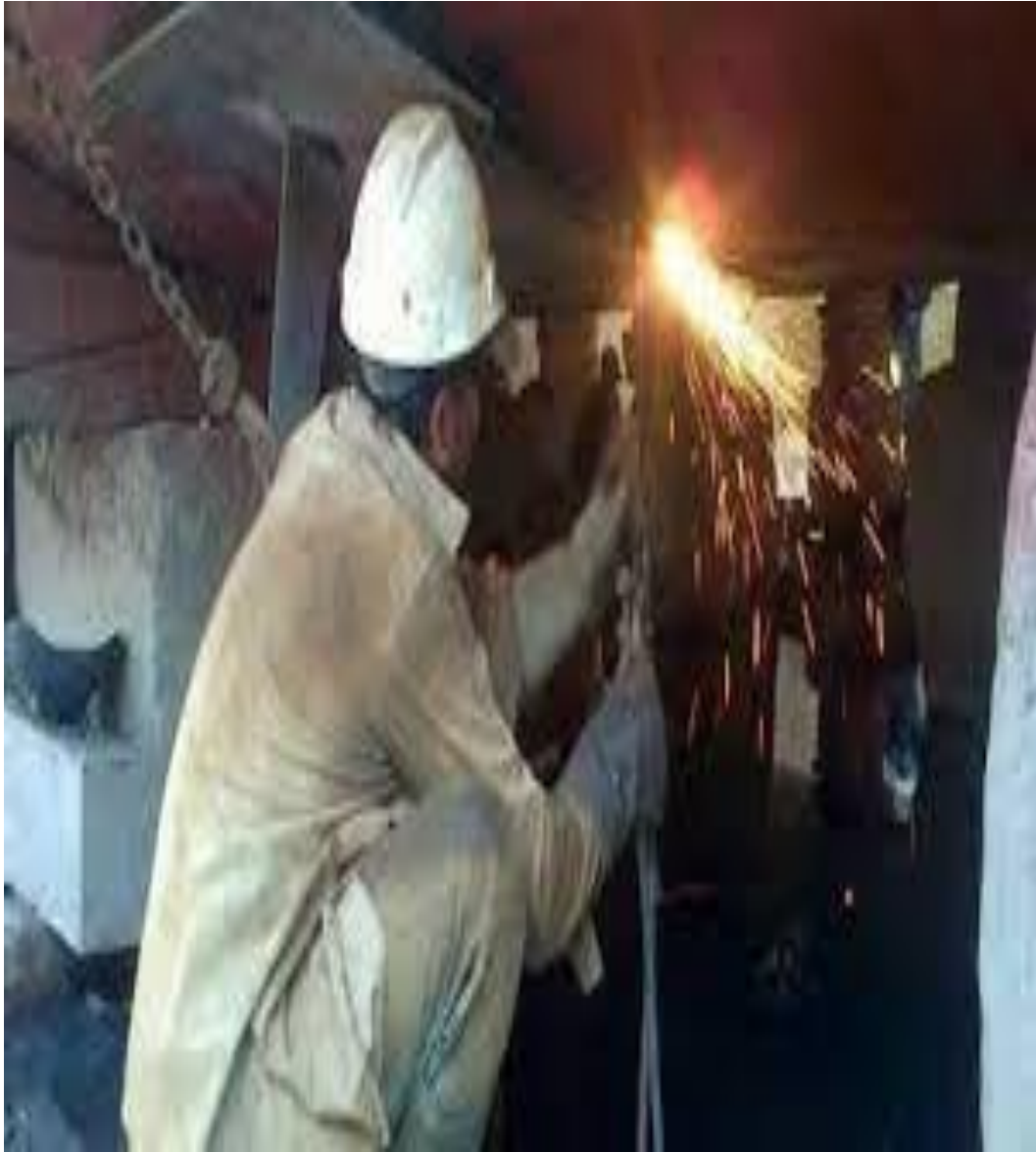
Lampiran 3 :Pengelasan pada lunas saat di docking
