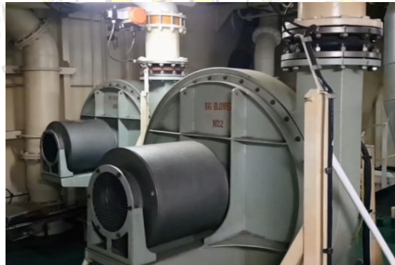
Gambar 2.4. Inert gas blower di MT. Prima XP
