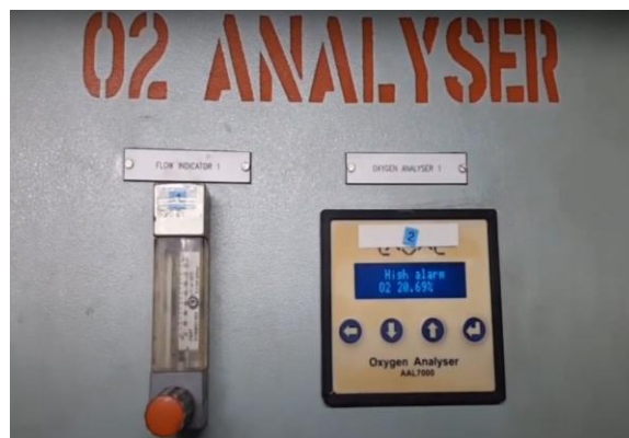
Gambar 2.9. Oxygen Analyzer IGG di MT. Prima XP Sumber: dokumen pribadi
