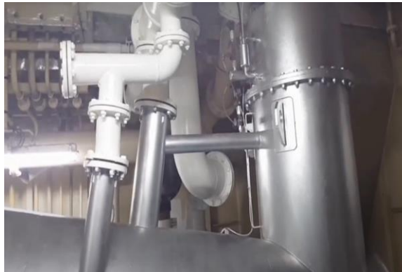
Gambar 2.2. Scrubber pada IGG di MT.Prima XP
