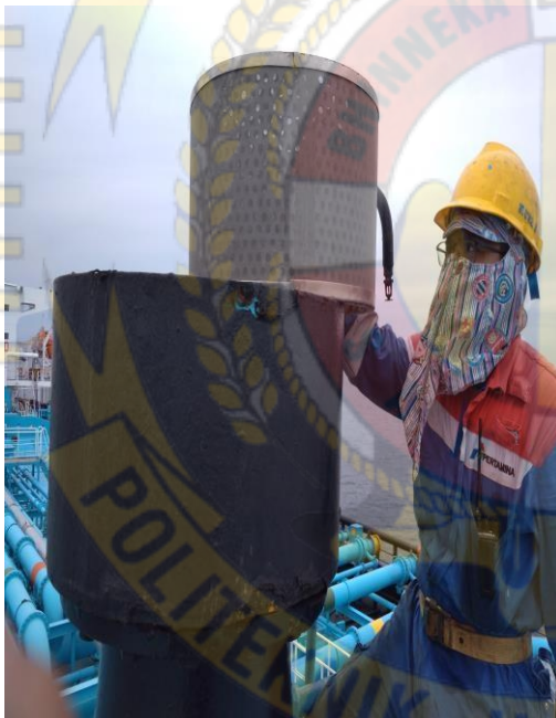
Pemasangan Flame Screen pada Mast Riser Proses pengencangan baut Flame Screen Mast Riser
