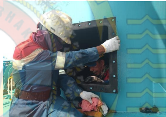
Membersihkan bagian dalam Deck Water Seal
