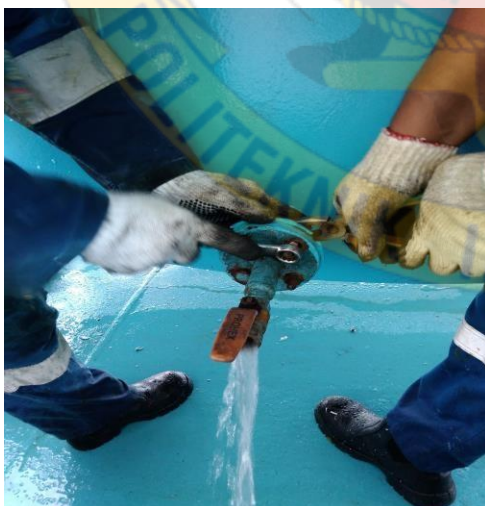
Membuang air di dalam Deck Water Seal untuk diganti dengan air yang lebih jernih
