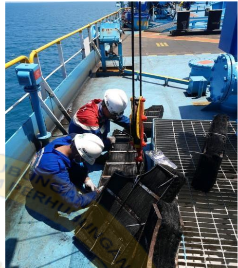
Membersihkan kotoran pada Demister
