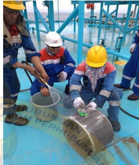
Pelepasan Flame Screen pada Mast Riser Pembersihan Flame Screen Mast Riser
