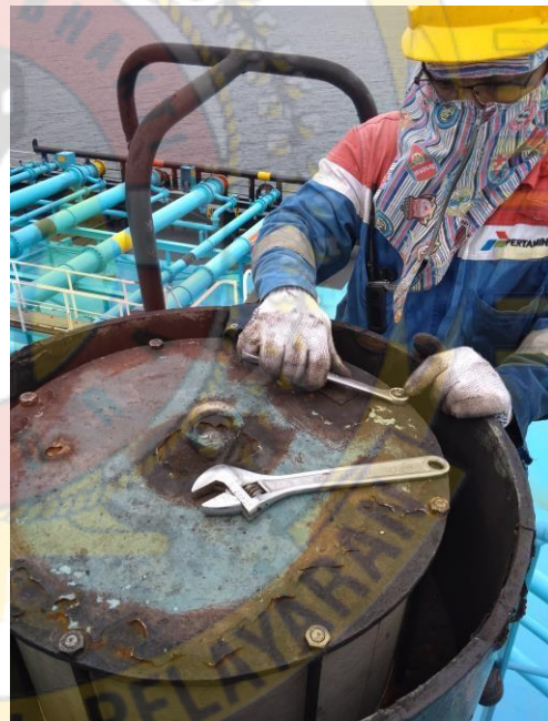
Pemasangan Flame Screen pada Mast Riser Proses pengencangan baut Flame Screen Mast Riser
