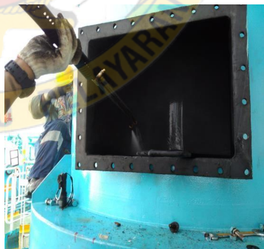
Penyemprotan bagian dalam Deck Water Seal
