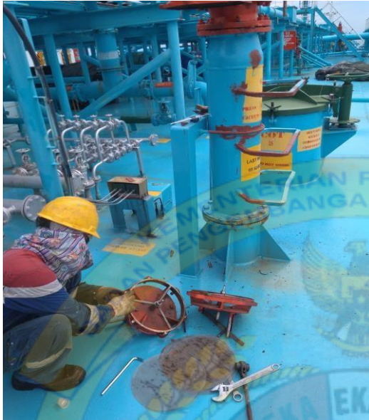
Maintenance katup pada P/V Valve
