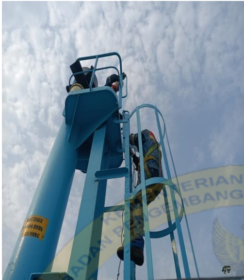
Pelepasan Flame Screen pada Mast Riser Pembersihan Flame Screen Mast Riser
